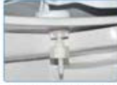
Klozet kapağı montaj vidası üstten klozete takılır.
