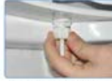
Konik rondela ile birlikte Quick Fix somunu cıkarta üzerinde çevirmeden, pratik bir hamle ile yukarı doğru bastırılarak sıkıştırma boşluğu alınır.
